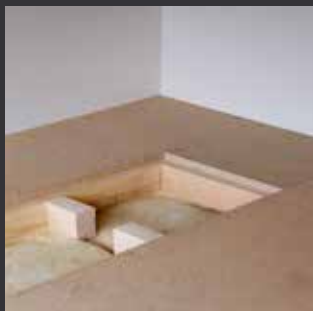
Golvbjälkar och kortlingar, c-c 300 mm.
