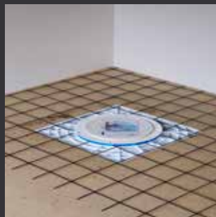
Primer PCI Gisogrund 404 på spånskivan till plastkanten samt armeringsnät av stål.
