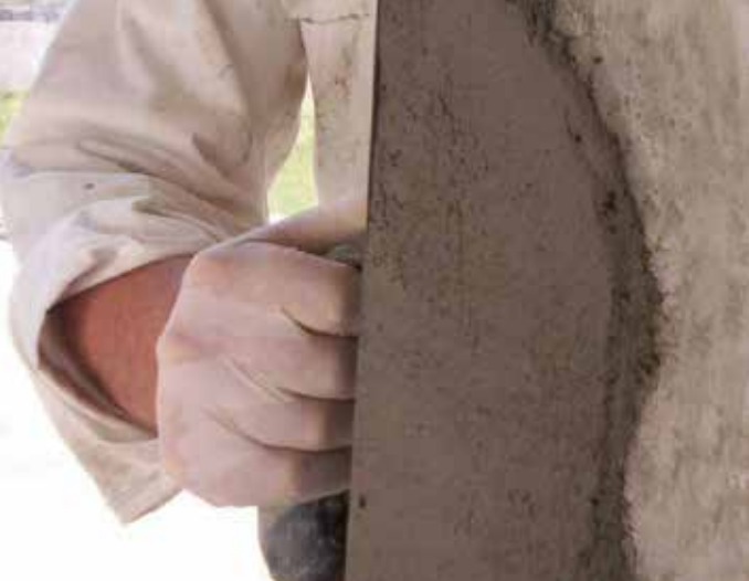
Reparation av hörn och kanter – bara ett av många användningsområden för det universella reparationsbruket PCI Nanocret® R2.
