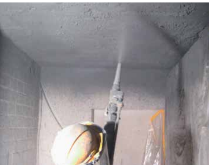
Tack vare sina utmärkta vidhäftningsegenskaper fäster PCI Nanocret® R3 vid vågrät användning, både manuell och maskinell applicering.
