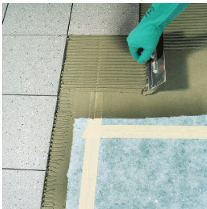
5. Låt fästmassan härda (ca 9 tim med PCI Flexmörtel S1 Flott och ca 3 tim med PCI Flexmörtel S1 Rapid, angivna härtider vid + 25 °C och 50 % RF).
