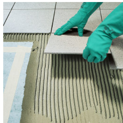
6. Läggnigen kan nu ske av keramiska plattor eller natursten, direkt på skivorna. Använd anvisad PCI fästmassa, och en tandspackel som ger full bruksfyllnad under plattorna. 7. Foga plattorna med anvisad PCI fogmassa.
