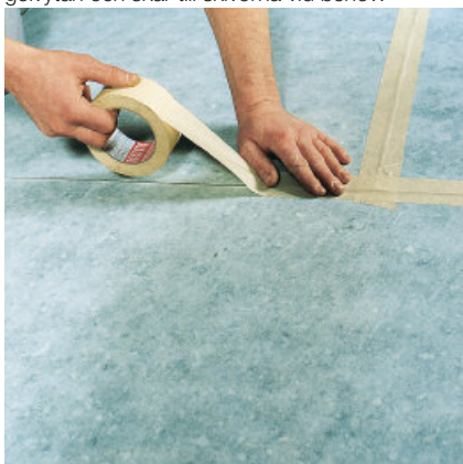
4. Tejpa alla skivskarvar med 20 mm bred, självhäftande "mållartejp" t.ex. Tesakrepp.
