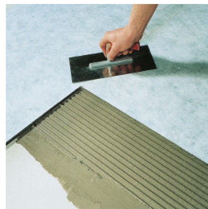
PCI Polysilent Plus skivorna används som stegljudsreduktion under beläggningar av keramiska plattor och natursten.
