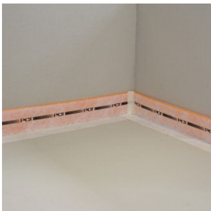
1. Kliста fast det självhäftande bandet, PCI Pecitape Silent längs väggar och pelare, för att inte överföra stegljudet till angränsande rum. Lägg ut PCI Polysilent skivorna löst över golvytan och skär till skivorna vid behov.
